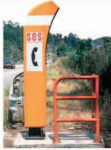
el teléfono de emergencia emergency phone
