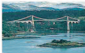
el puente bridge
